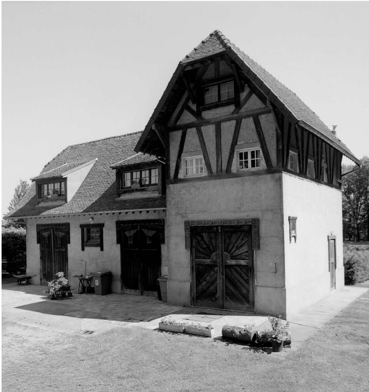
Vue d'ensemble de la maison du gardien construite dans le style norvégien.
