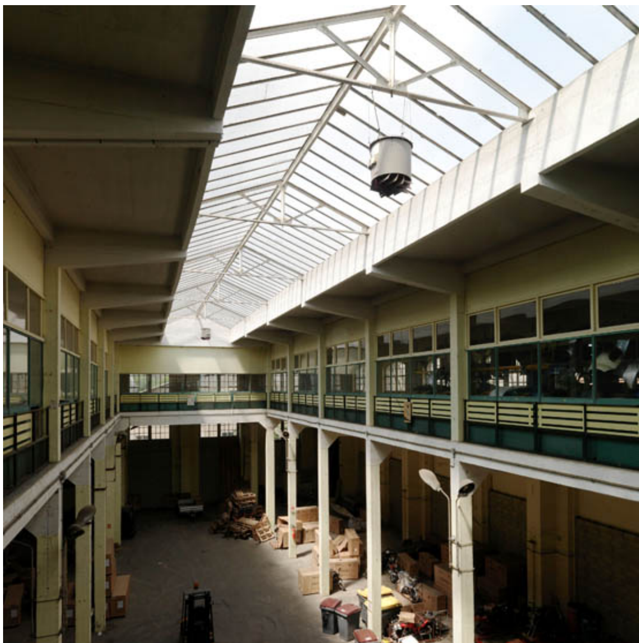
Vue intérieure du magasin général (1915). Structure en béton.
