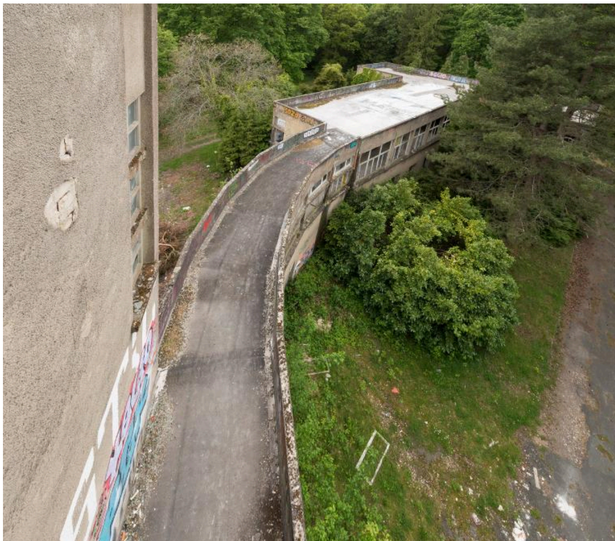
pavillon Bonnefoy-Sibour, vue prise depuis le toit vers l'extrémité ouest du bâtiment
