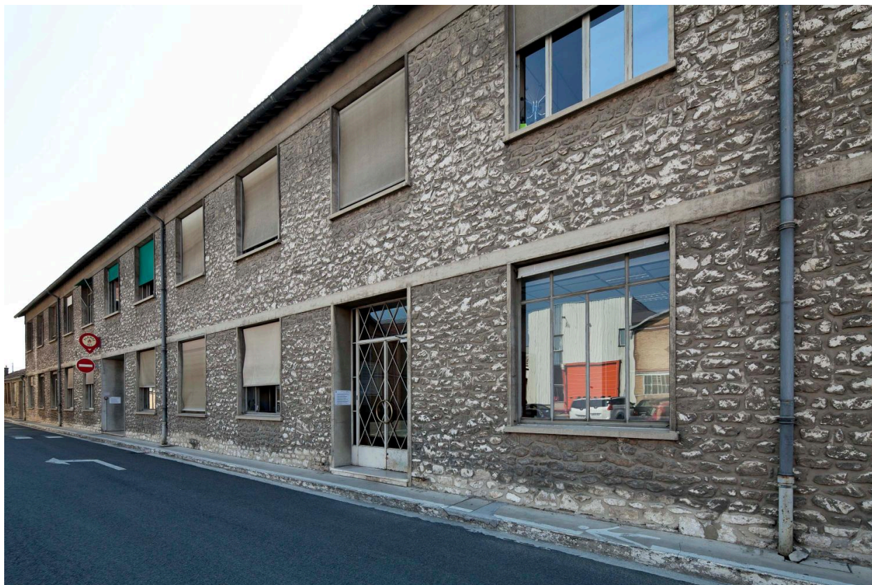
Administration, ancienne scierie Jodot, 1934-1950. (réf. Département de Seine-et-Marne : IVD77_2013_77_00354)
