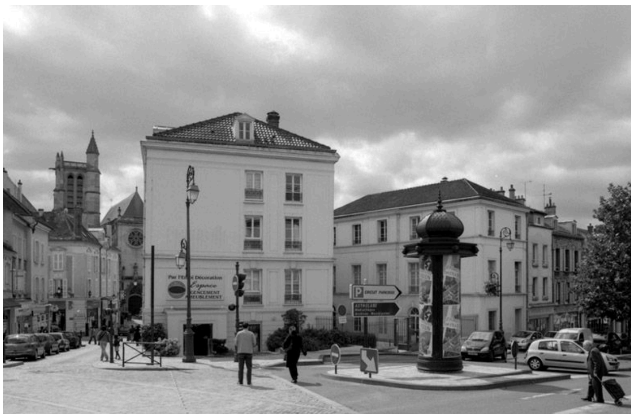
Elévation ouest, sur le boulevard Victor-Hugo.
