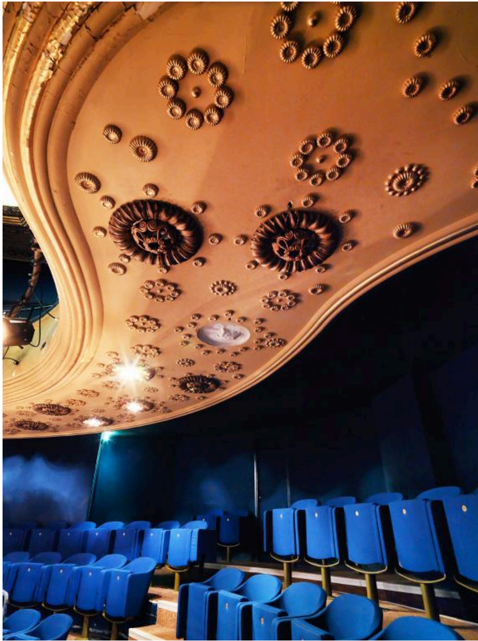
Plafond des balcons
