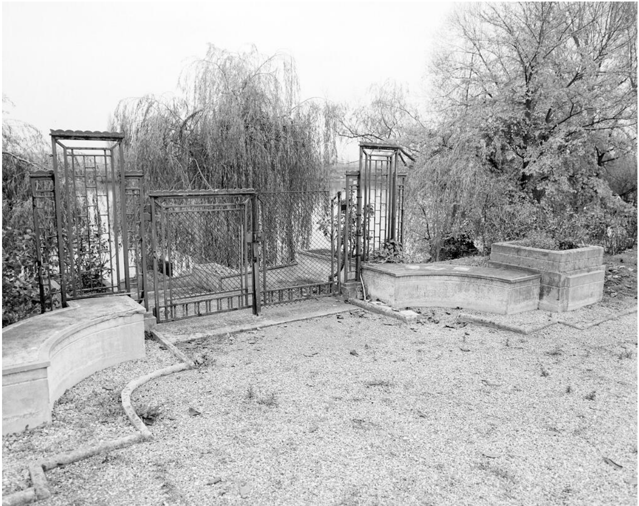
Grille d'accès à l'escalier de l'embarcadère.
