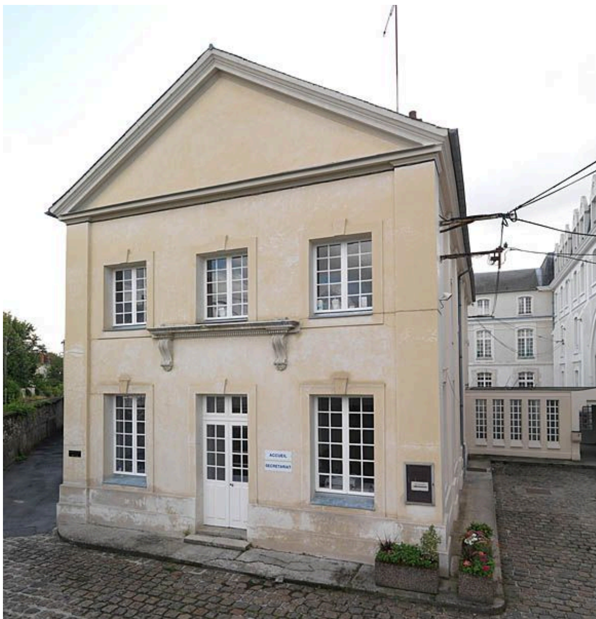
Façade de l'ancienne chapelle des soeurs de la Visitation.
