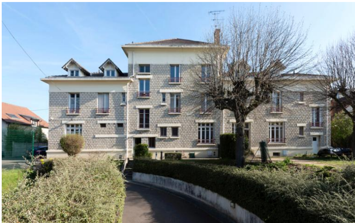
La façade arrière du bâtiment sur rue.
