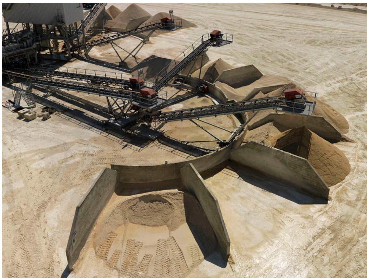
Plateforme - installation secondaire.
