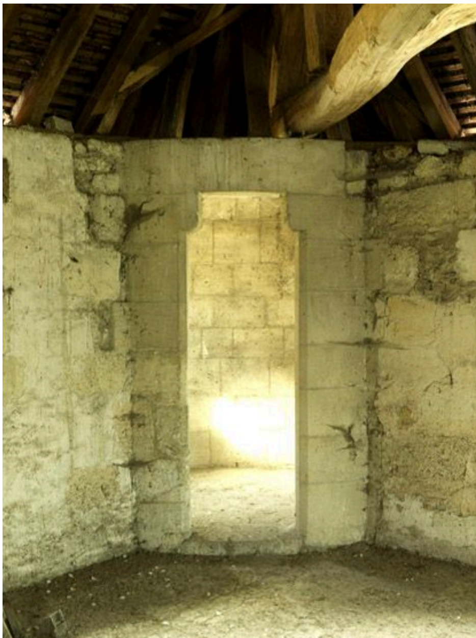
Vue intérieure : le comble et l'une des tourelles d'angle, vue de face.
