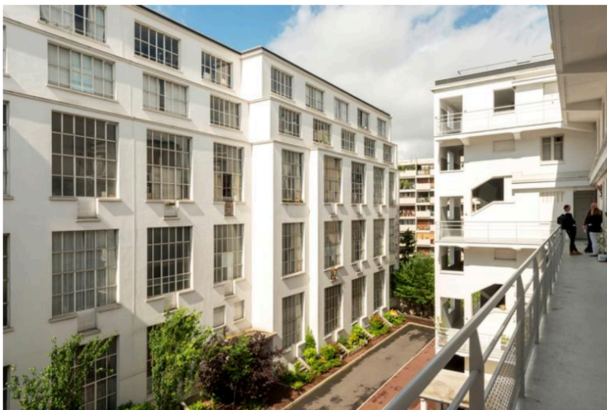
Vue prise depuis les coursives du bâtiment principal (3e étage) (2)
