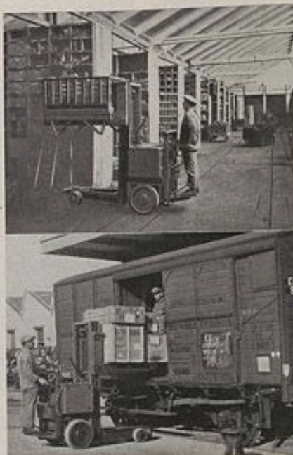
Tracteurs électriques Fenwick, avec plateforme élévatrice, utilisés par le Magasin Général de Villeneuve-Prairie.
