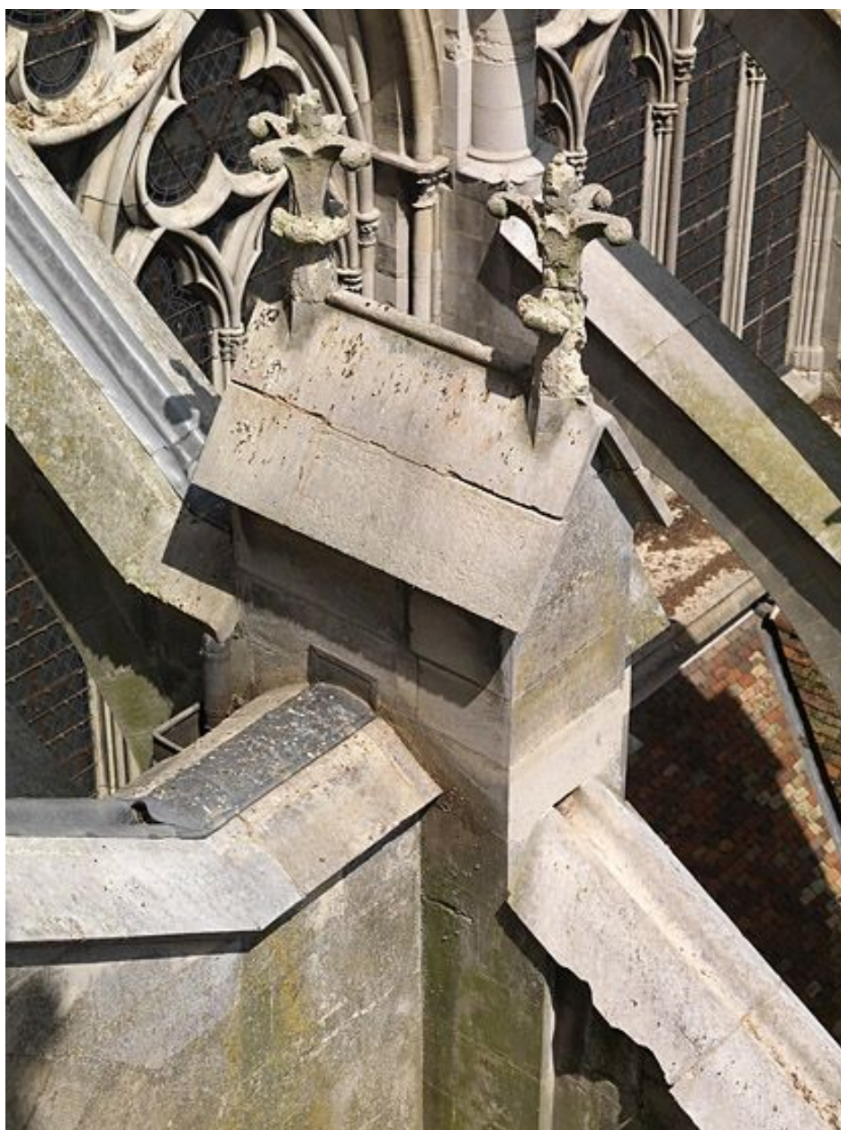
Détail de l'arc-boutant à la jonction du chœur et du bras sud du transept : le couronnement de la culée intermédiaire, à décor de fleurons.
