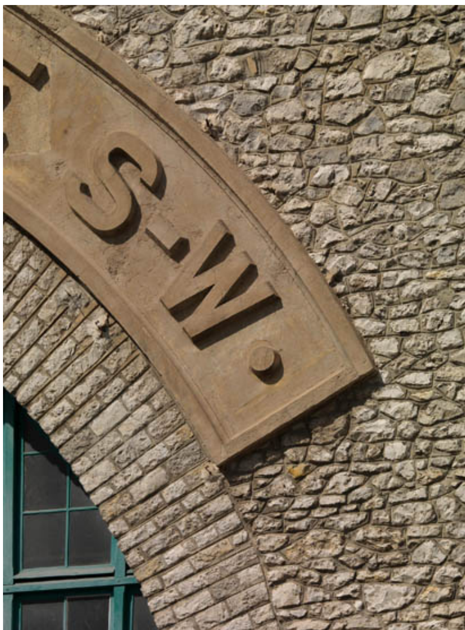
Détail de la façade de la nef centrale en meulière blanche. Enseigne Schneider-Westinghouse en ciment moulé.
