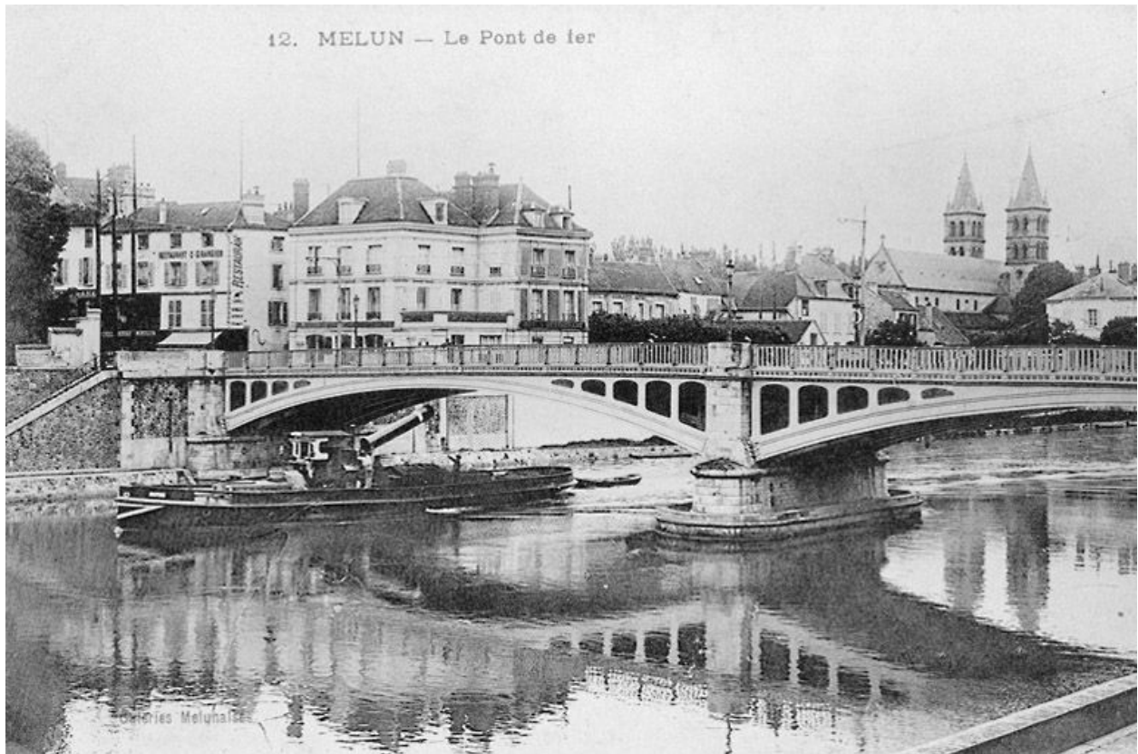
Partie nord du "pont de fer", vue de l'aval, vers le début du 20e siècle. Carte postale. (Musée municipal de Melun. inv. 983.2.64)
