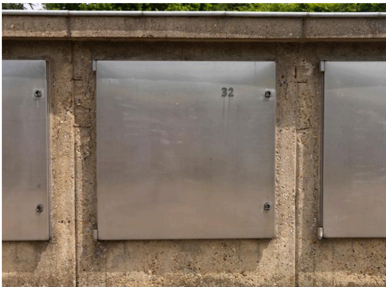
Détail d'une porte en inox fermant une case d'enfeu.
