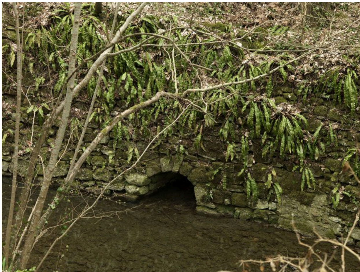
Débouché du canal de fuite dans le ru de Fontaineroux.
