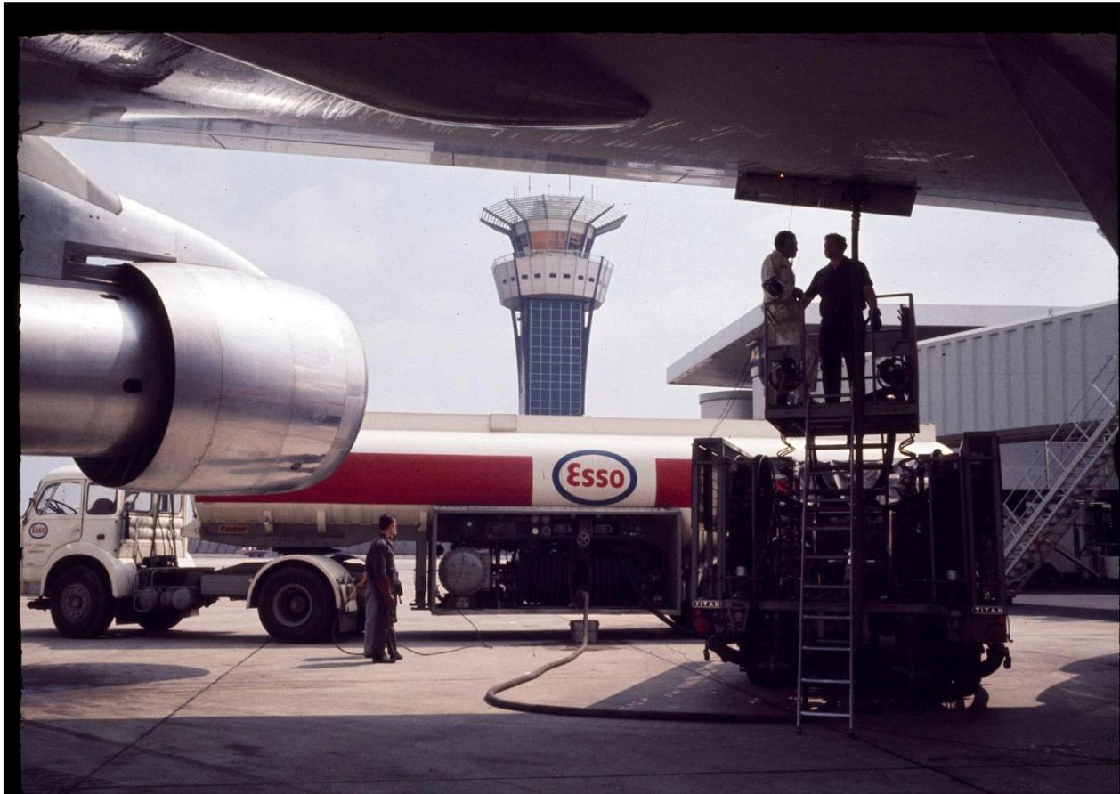
1970, Boeing 747, distribution de carburant par un avitailleur (Hydrant système).
