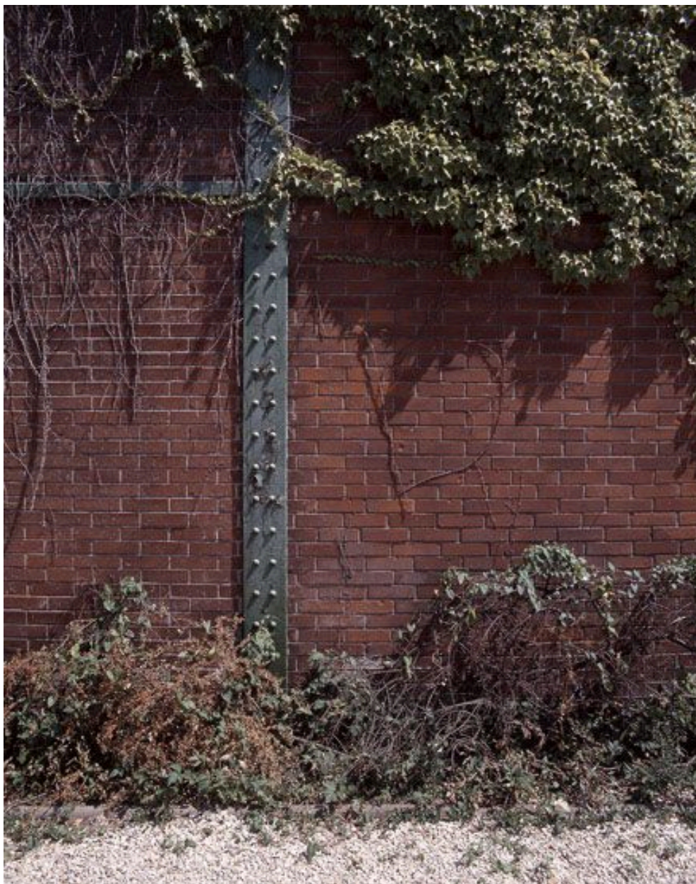
Détail d'un élément du pan de fer hourdé de briques.
