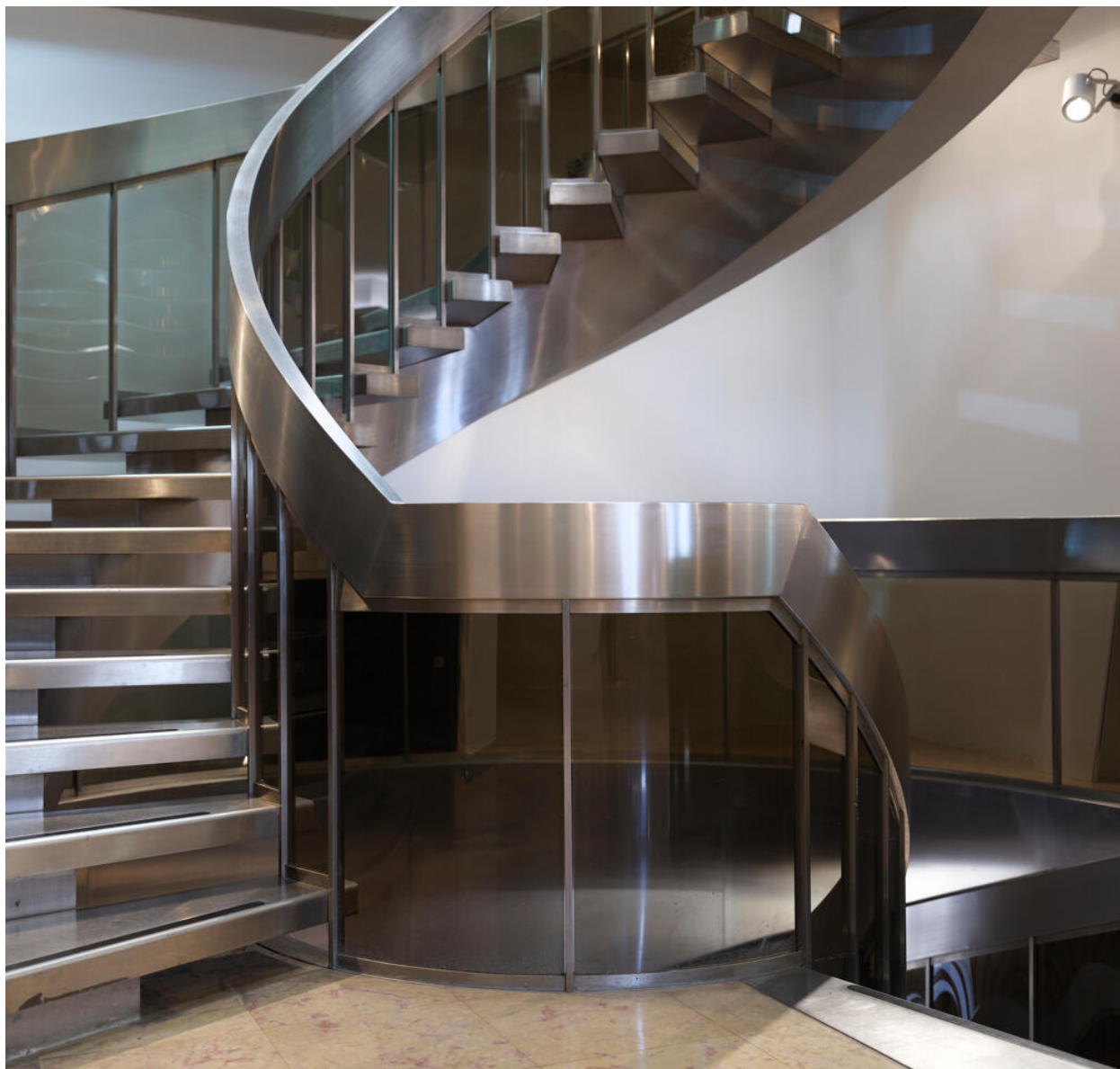
Escalier en vis desservant les bureaux du deuxième étage. Détail de finition de l'acier inoxydable.
