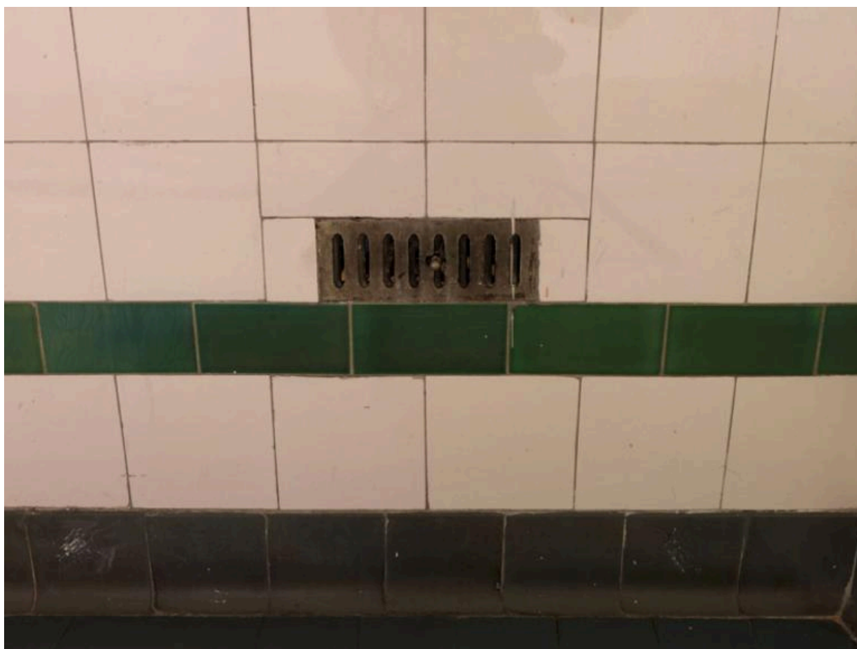
Détail d'une grille d'aération.
