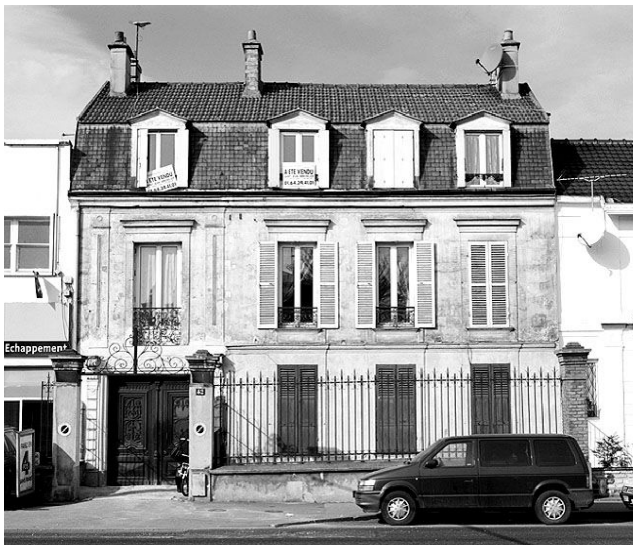
Maison 42, avenue Thiers.
