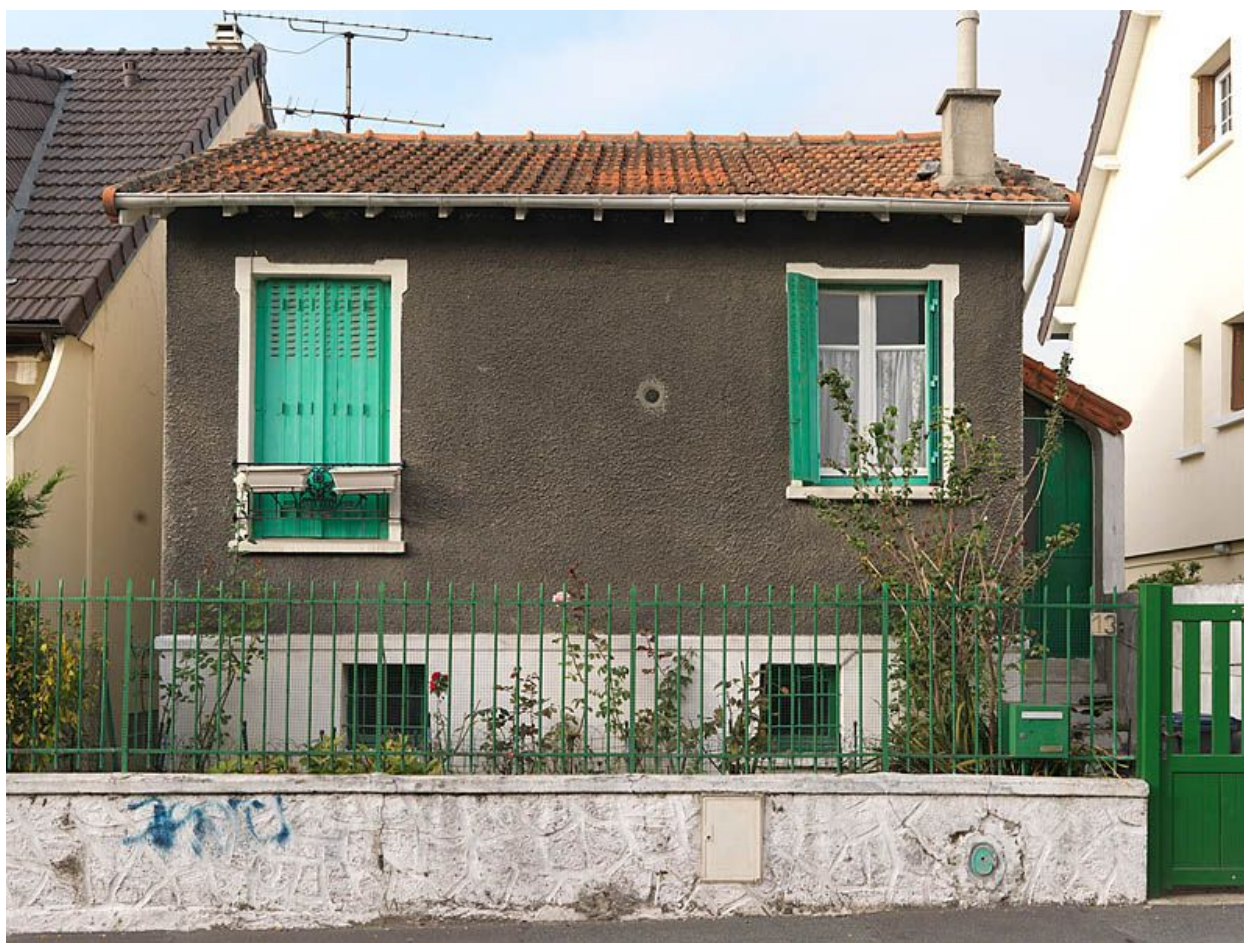
Thiais, maison, 13 rue de la Liberté. Vue d'ensemble.
