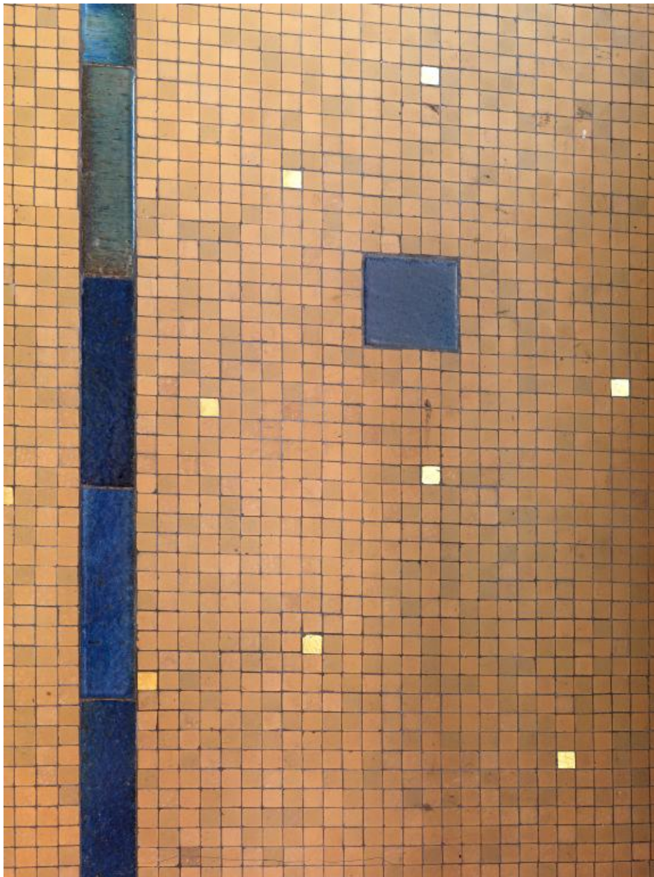
Détail du pavement mural du hall d'entrée
