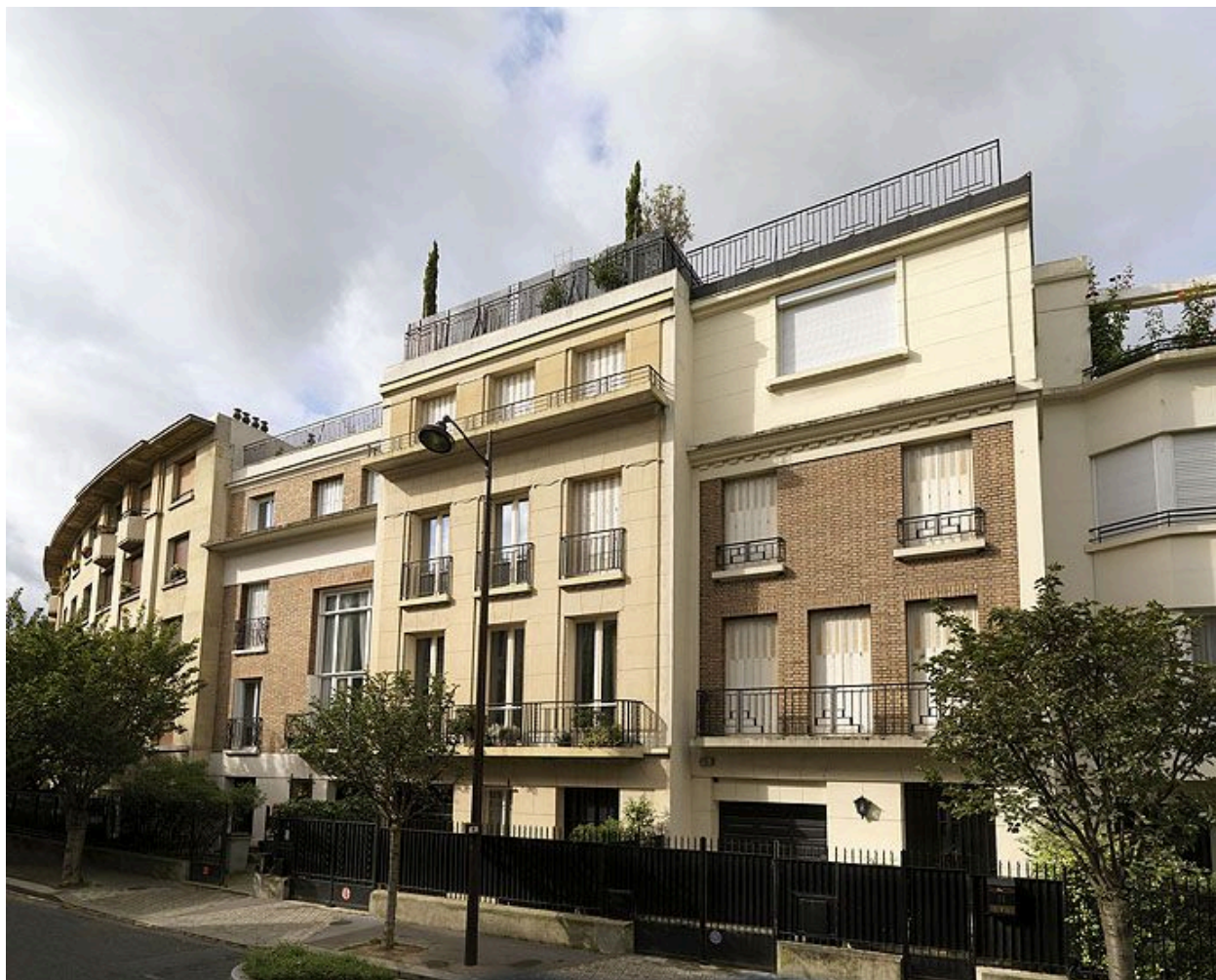
92, Neuilly-surSeine, lotissement concerté, 1, 2, 4, 6, 7, 9, 11, 13, 15, 17, 19 rue de Longpont. Les maisons alternant brique et enduit côté impair.
