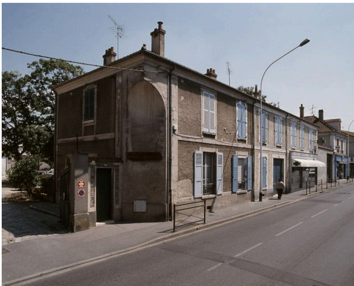
Vue du bâtiment d'habitation fermant la cour sur le boulevard H.-Barbusse.
