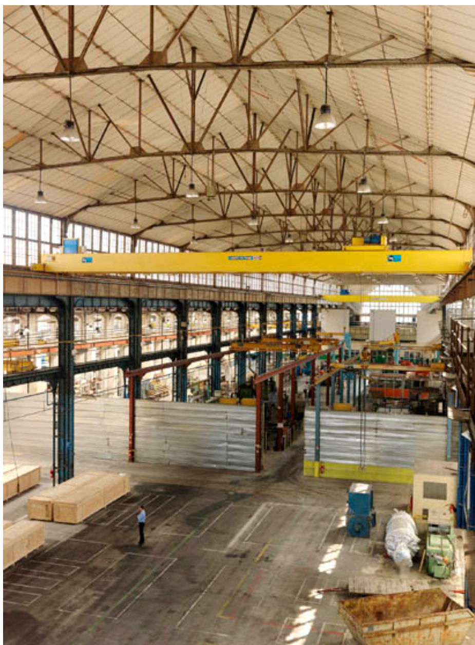
Vue intérieure de la nef centrale. Montage, machines-outils (1901-1903). Actuellement entreprise Jeumont Electric. Poteaux et charpente métalliques.
