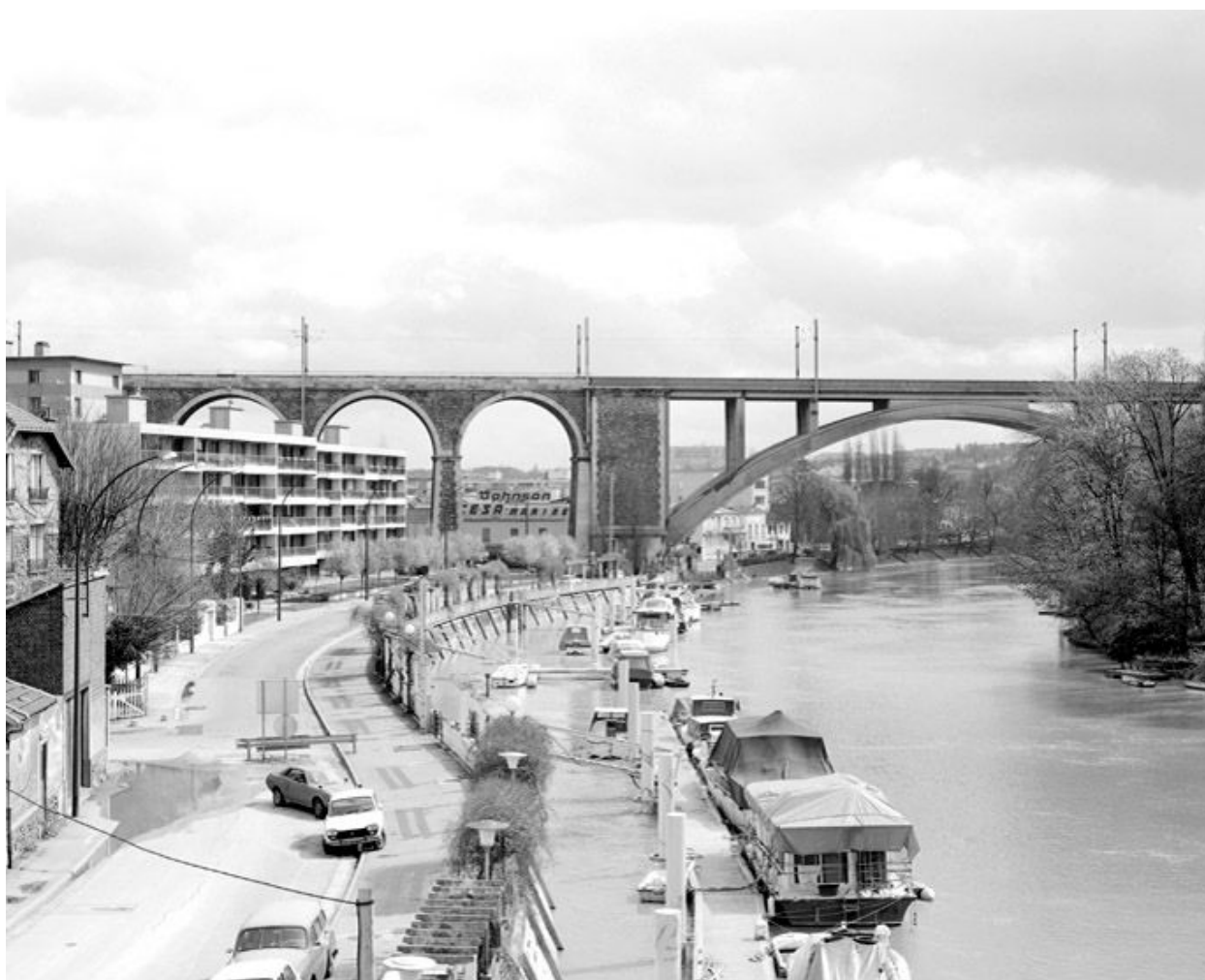
Vue partielle prise d'aval.
