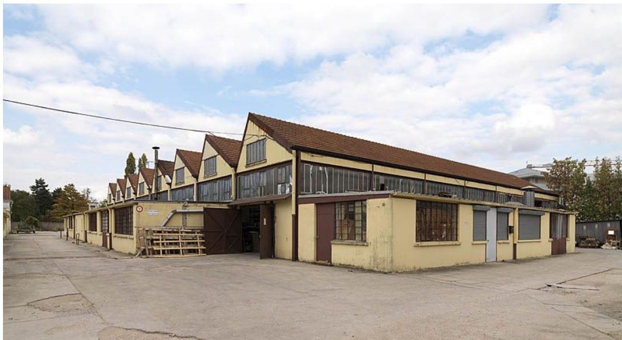
Vue de l'atelier de découpage et d'emboutissage. Bâtiment couvert de shed.
