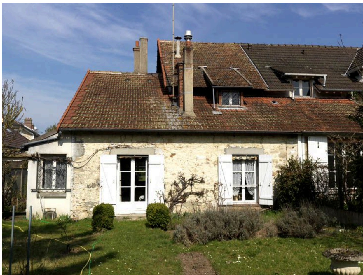
Façade arrière, extension postérieure à la construction de l'atelier.
