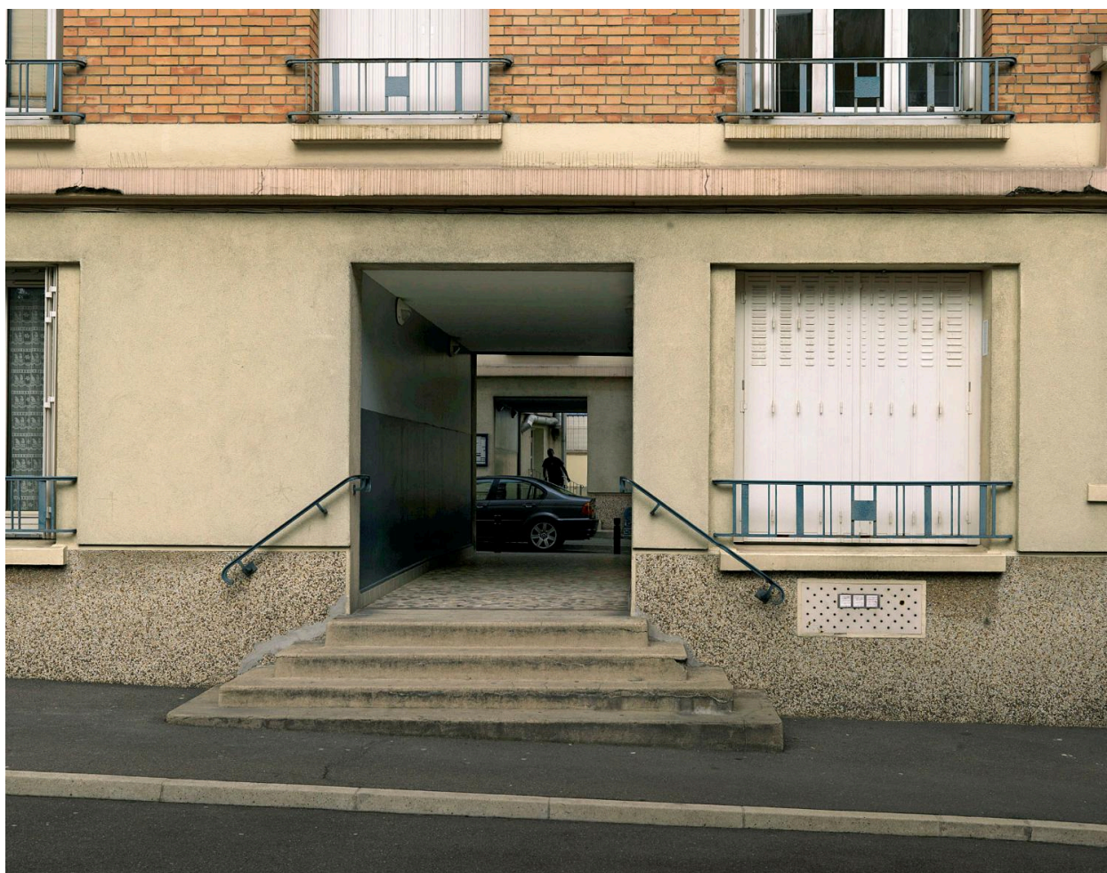
Cité du Foyer des Invalides et des Anciens Combattants. Vue d'un passage traversant dans un bâtiment.
