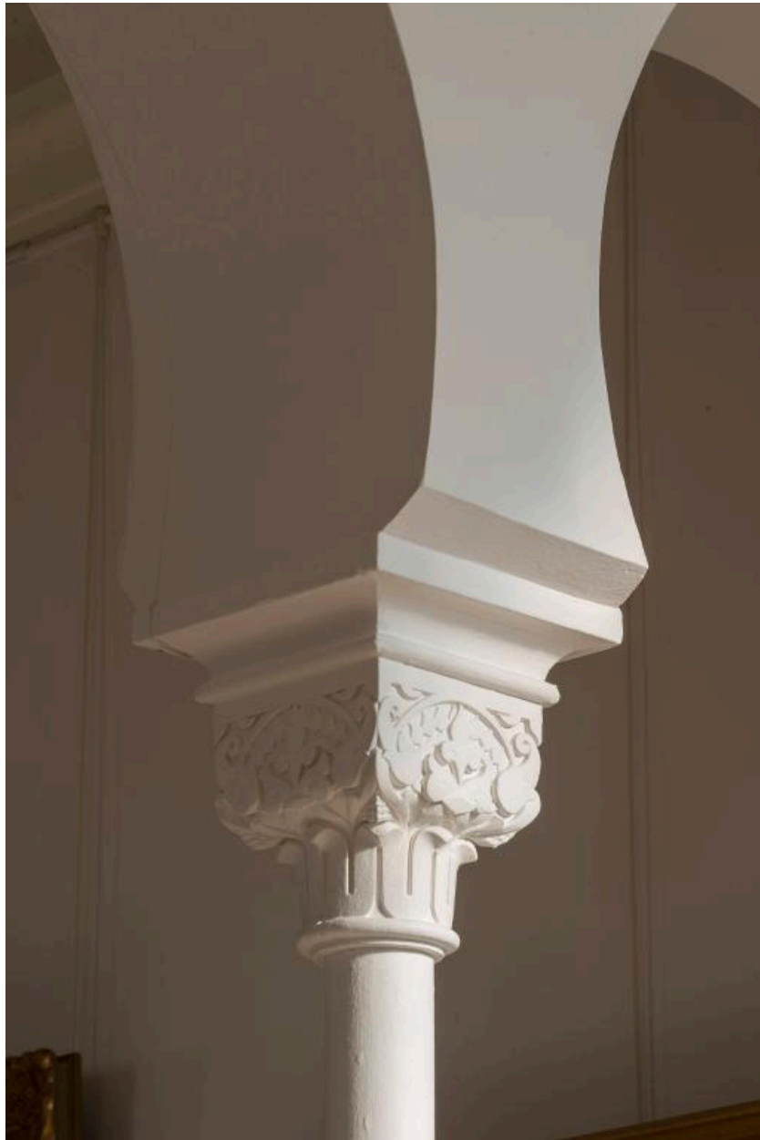
Vue d'un chapiteau en fonte, détail de l'arcature du premier étage
