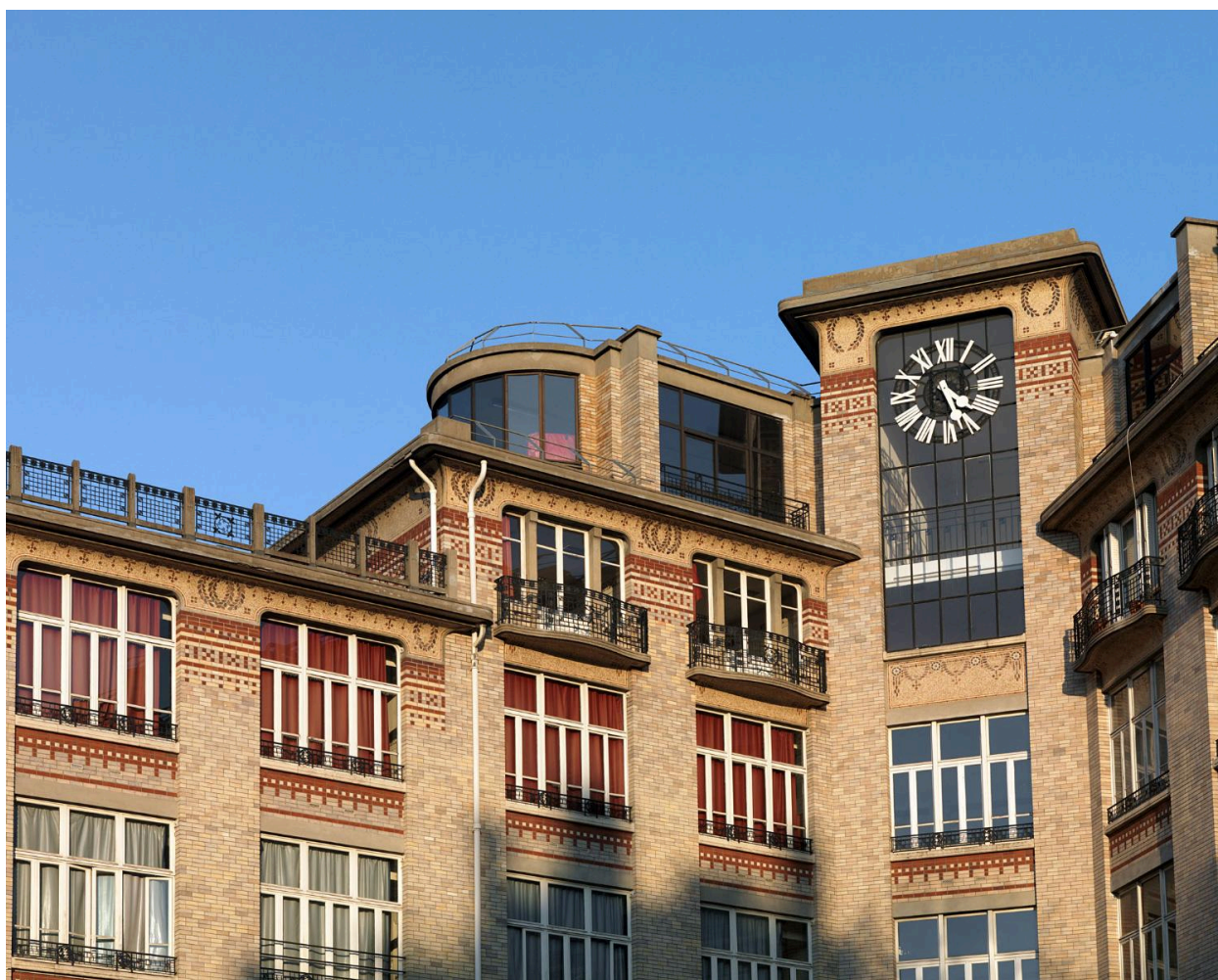
Détail du beffroi et de son horloge.
