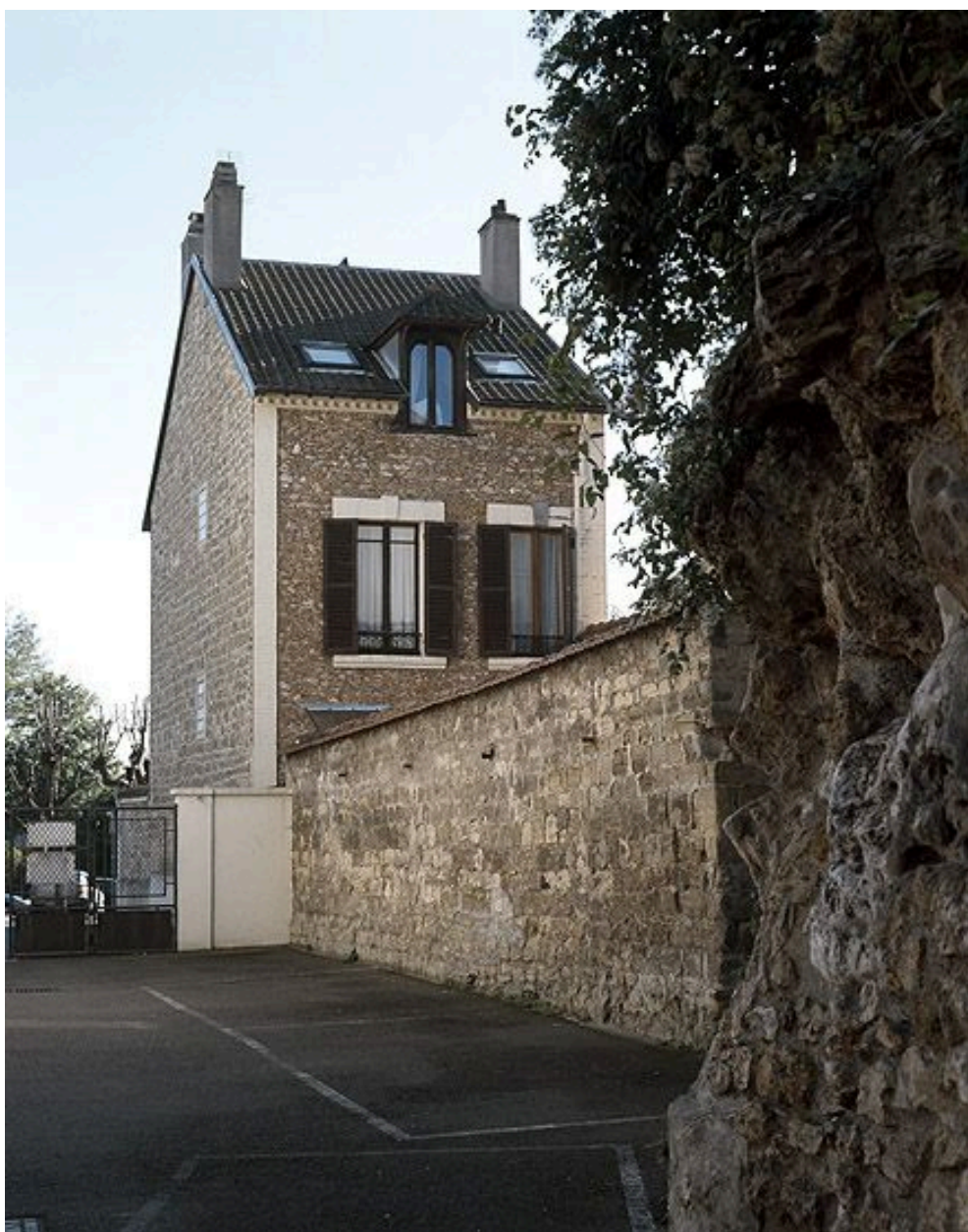
Vue d'ensemble de la façade arrière.
