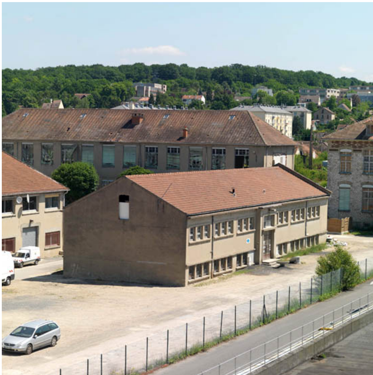
Vestiaires, lavabos et douches (1951).
