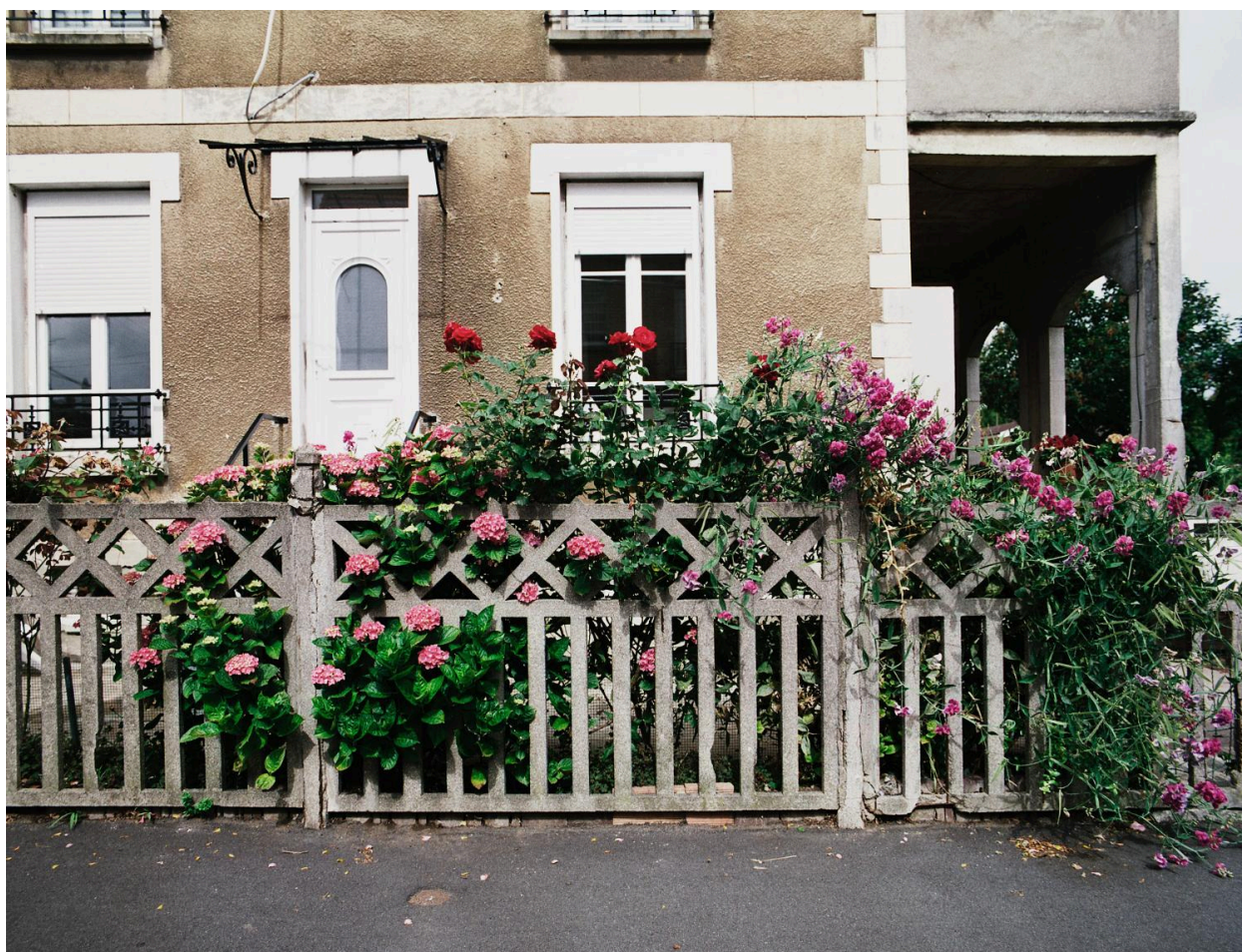
Clôture en ciment armé.
