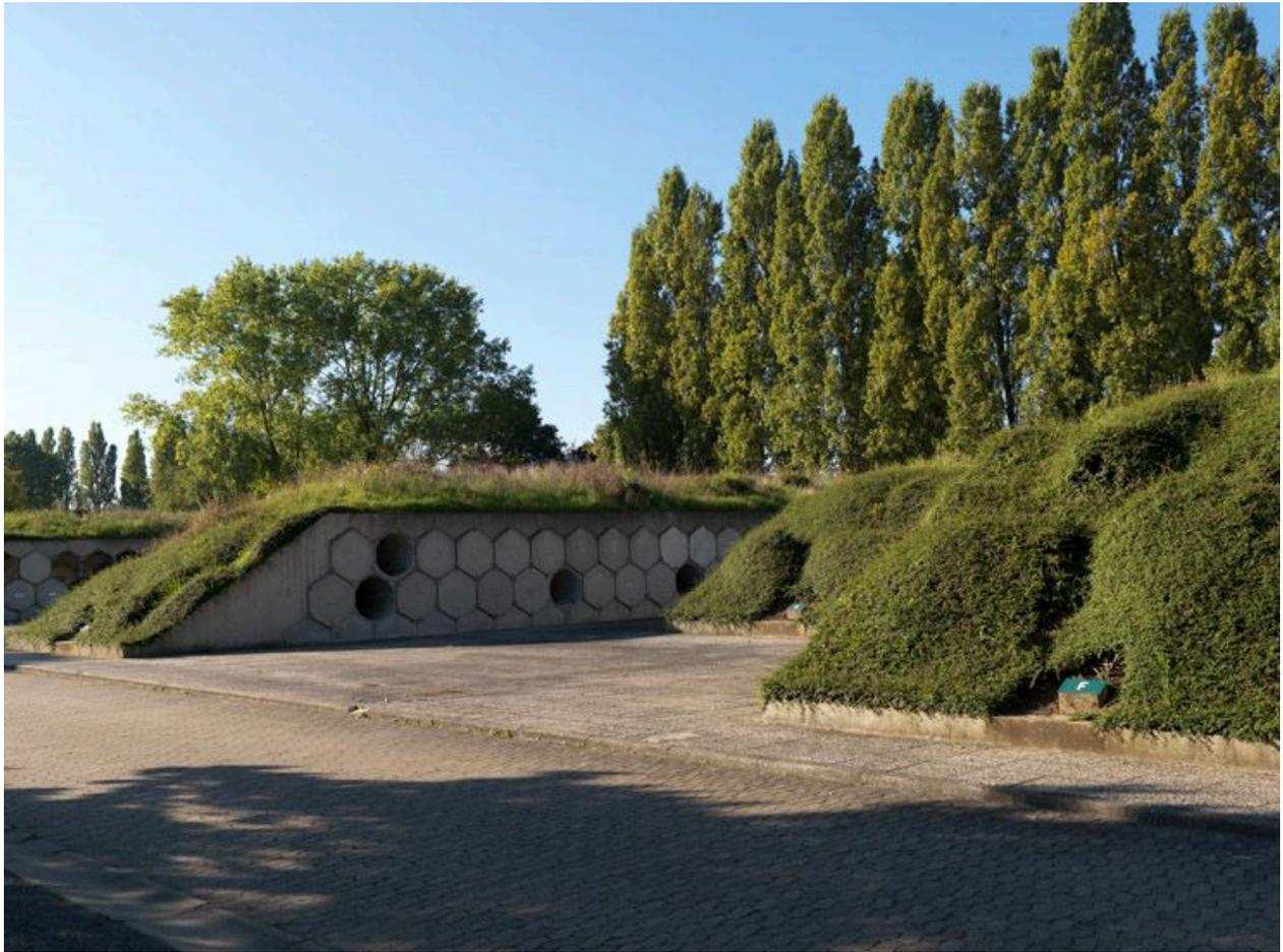
Vue des allées d'enfeus entièrement couvertes de végétation rampante, camouflant les cheminées d'aération. Le modèle d'alvéoles hexagonales préfabriquées a été dessiné et breveté par Robert Auzelle.
