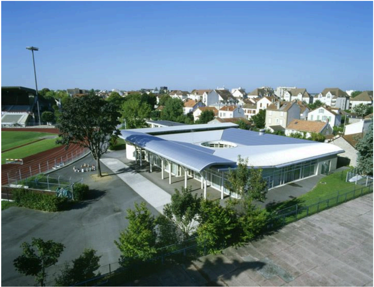
Vue du bâtiment au nord des pistes, depuis le toit de la piscine.
