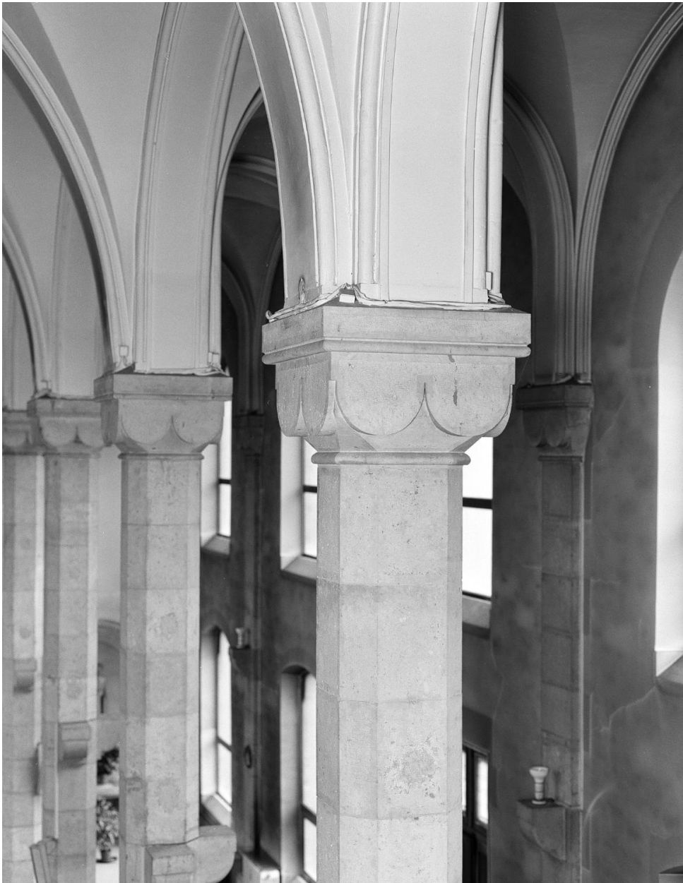
Détail des chapiteaux des colonnes de la nef.
