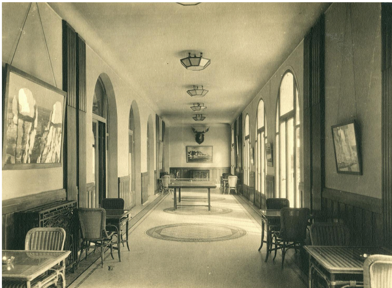
Vue de la galerie-vestibule qui ouvre, côté sud, sur le jardin. S.d., vers 1930. CIUP, centre de valorisation du patrimoine, P/TP-A 2-PI 108.
