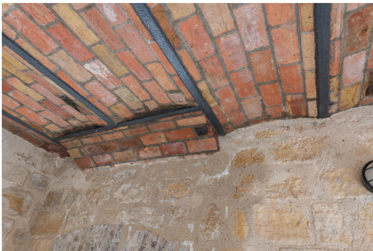
Voûtes de couverture dans la remise aux bateaux.
