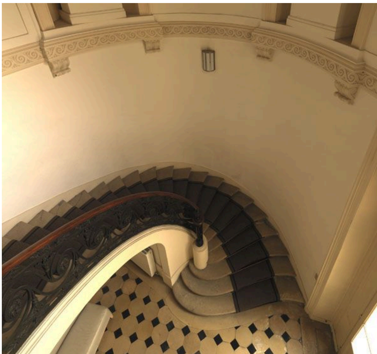
Partie de l'escalier en plongée.
