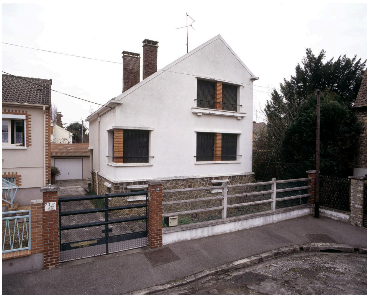
Vue d'ensemble de la maison reconstruite pour M. Rastoul au 20, rue du Vercors.
