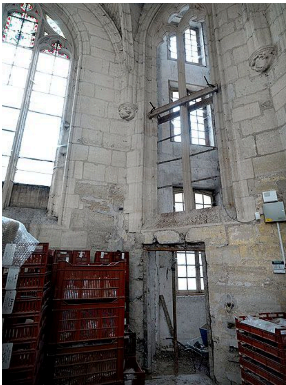
Détail du pan coupé nord de l'abside.
