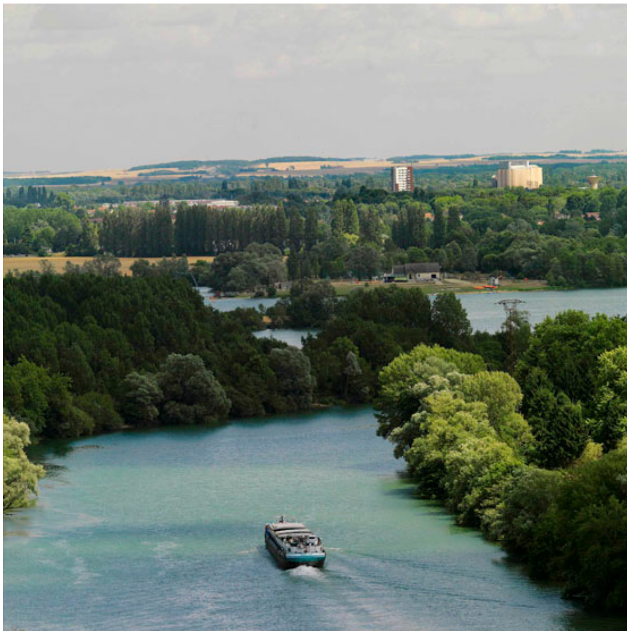
Silos de l'UNCAC Invivo de la Grande Paroisse. Paysages autour du site. Vue sur la Seine depuis la tour de travail du silo 6.
