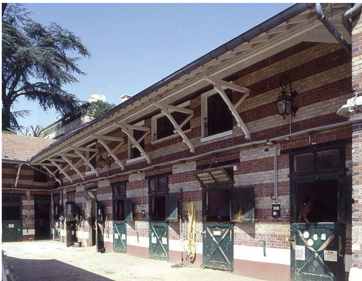
Cercle hippique du bois de Vincennes, , 8 rue de Fontenay. Vue des écuries.
