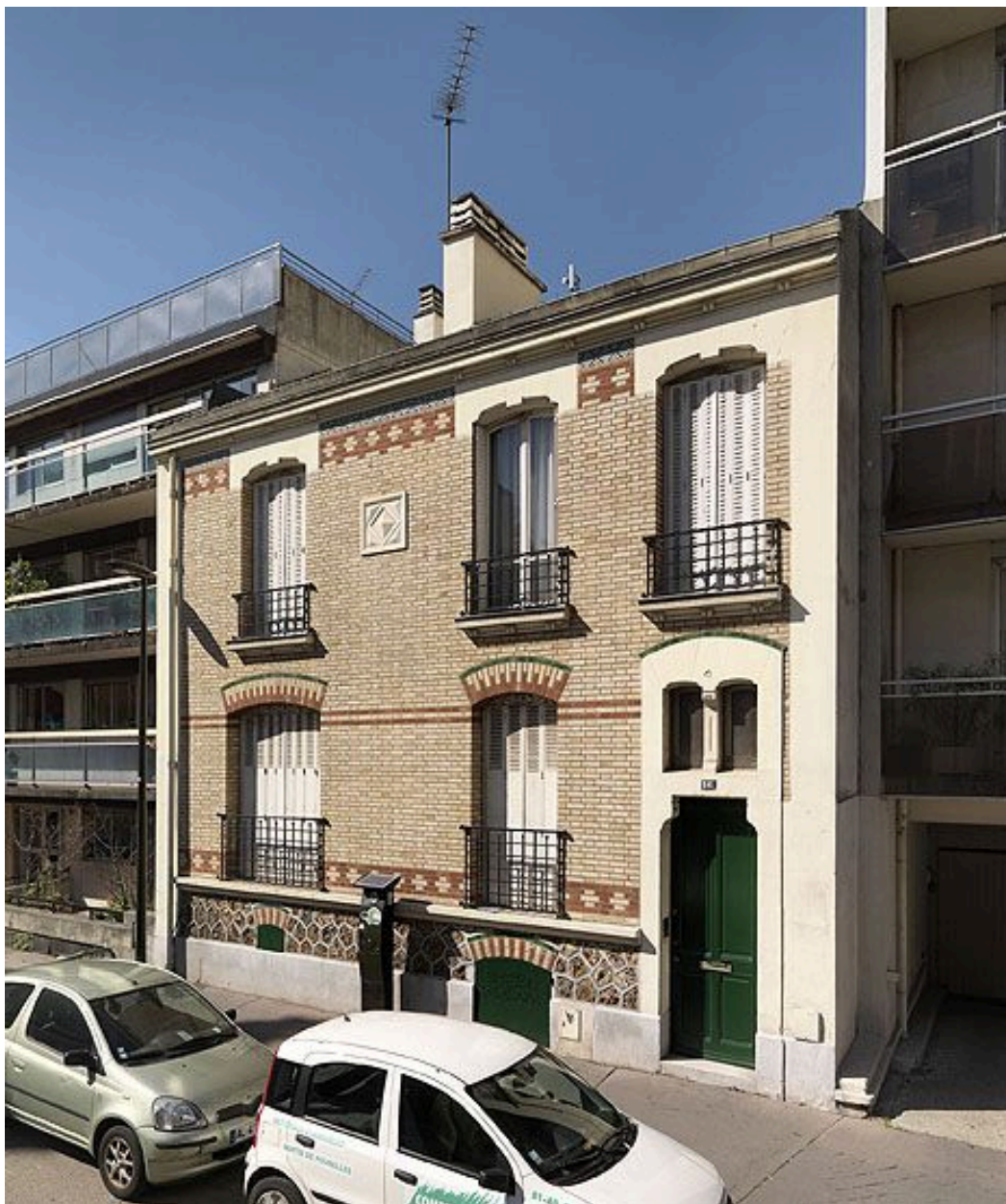
92, Boulogne-Billancourt, maison de monsieur Popp, 16 bis rue de l' Ancienne-mairie . Façade sur la rue.
