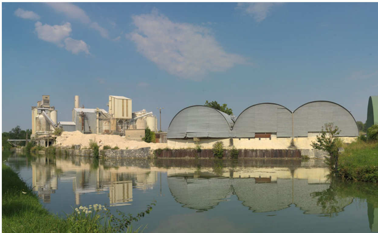
Vue extérieure depuis le canal du Loing.
