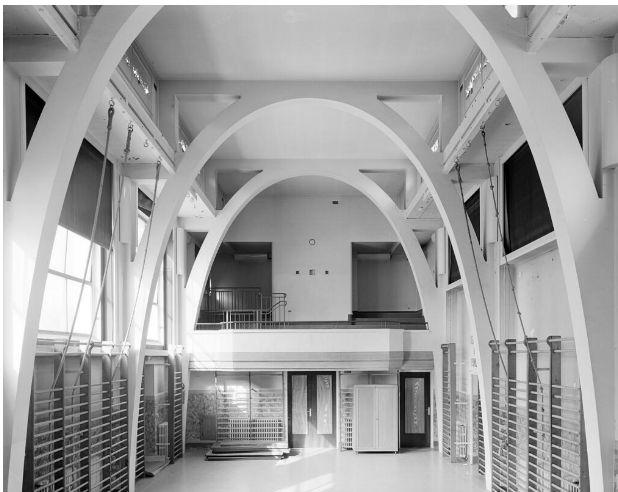
Gymnase. Salle des fêtes. Vue intérieure, vers l'entrée. Ecole Maternelle, Ecole Primaire dite Ecole Anatole France
